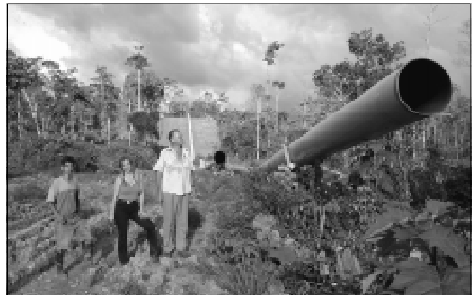
Baustellenbesichtigung in Ecuador: Dr. Goodland findet offensichtliche Verstöße
